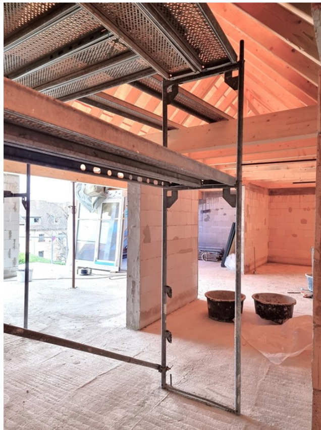
Dachstuhl von innen
