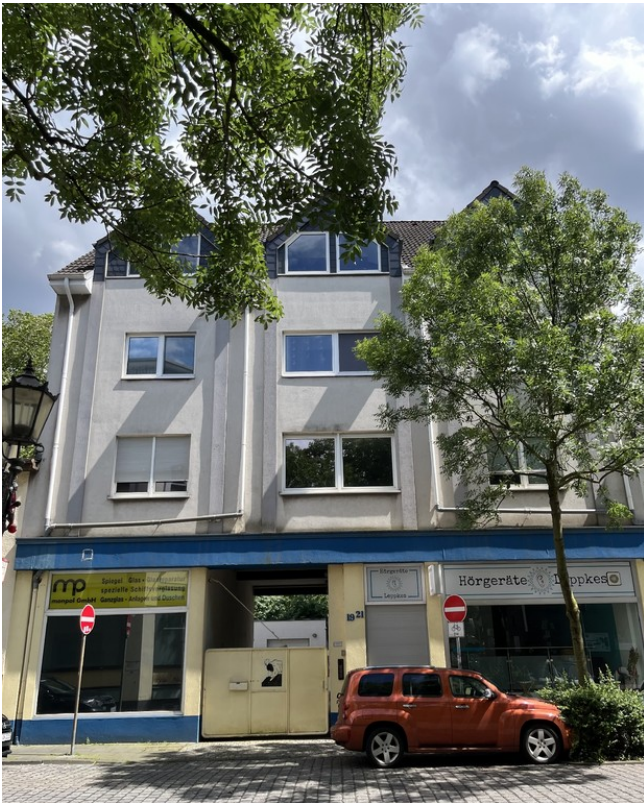
Hausfront mit Toreinfahrt
