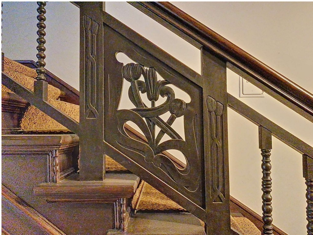
Detail Treppenhaus Vorderhaus
