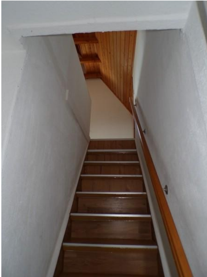
19 Treppen - aufgang II.OG
