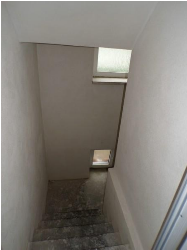
16 Haus 1 - Treppe zum Keller
