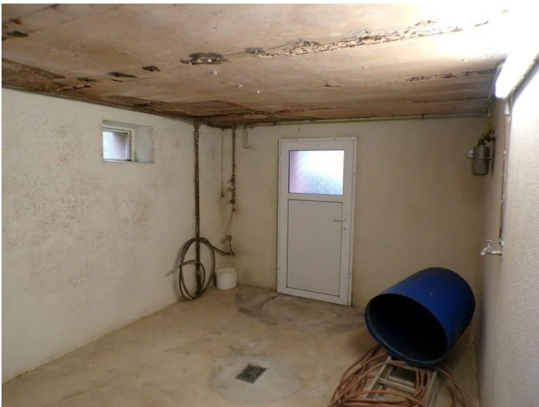
19 Haus 1 - Kellerraum 3 (mit
