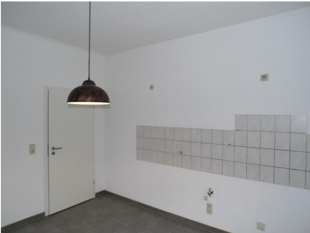
9 Haus 1 - EG Küche
